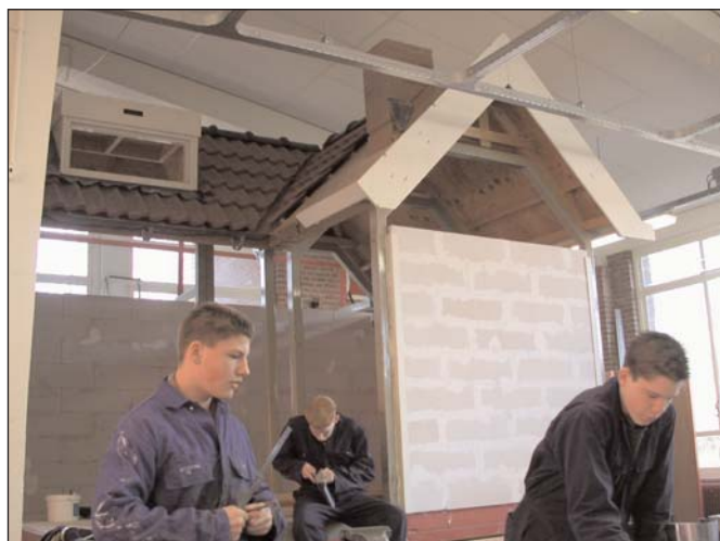
Vmbo-4-leerlingen bij het huis in aanbouw in het Canisius College. Binnen twee maanden moet het huis gereed zijn om er de echte installatiepraktijk te simuleren.
